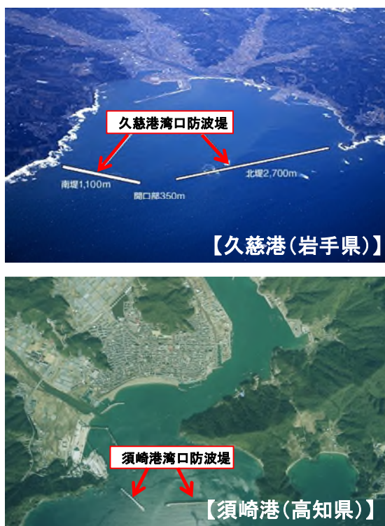
図 3.5-2 津波防波堤の整備（岩手県久慈港、高知県須崎港）
