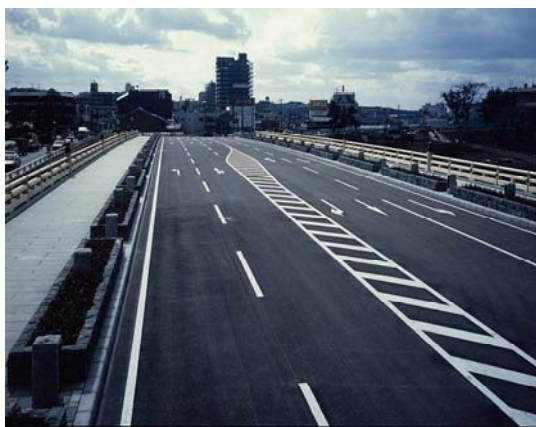
「宇治市・ 宇治橋橋梁整備」 高欄・桁隠しに 木材が使用され ている。 (第8回街路事業 コンクール特別賞)
