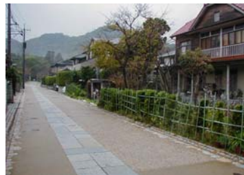
下関市長府地区覚苑寺参道線 (旧武家屋敷地区における歴史的参道空間を再生するため、石畳＋土系舗装や石組側溝が再整備された)
