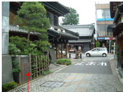
沿道民地内を借地し設置された地上開閉機
