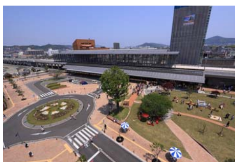
「日向市駅周辺地区」 (駅・駅前広場・周辺街路の統一感のある空間デザインによる良質な景観整備事例)
