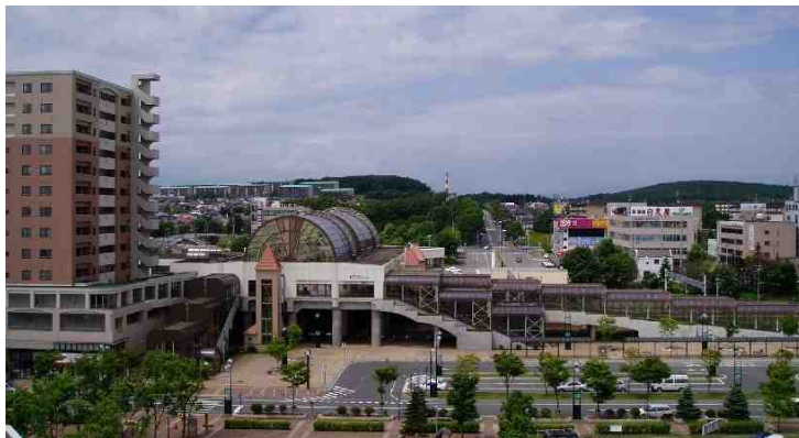
駅部およびエルフィンパークの外観
