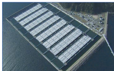
Oil storage bases 石油備蓄基地
