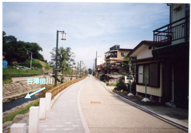
河川のもつ自然、周辺に点在する歴史や文化資源等を活かした歩車道共存道路を目指して、周辺環境に配慮し、車道部を土色の排水性コンクリート舗装、歩道部を赤桜の御影石舗装として統一
