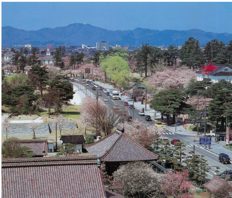
羽黒橋加茂線(事業区間)の全景
