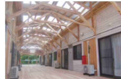
屋根付きウッドデッキの設置
