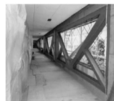
鉄骨ブレースによる壁の補強
