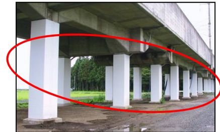
鋼板を巻く耐震補強により倒壊の被害なし
