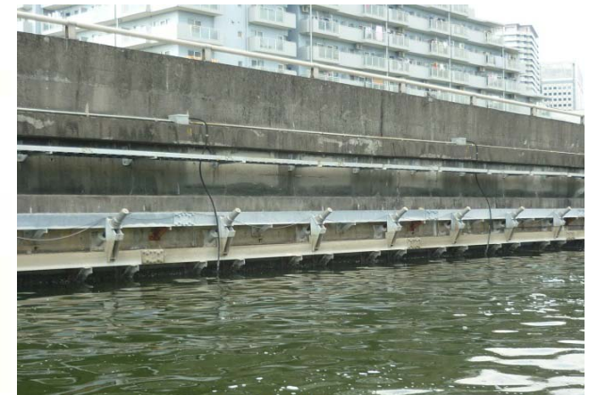
グラウンドアンカーによる補強 (平成20年)
