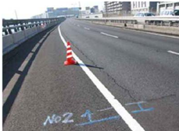
矢板変位による路面ひび割れ
