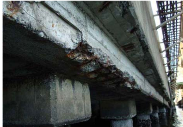
鉄筋腐食によるコンクリート剥落
