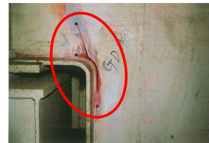
鋼桁切欠部のクラック
