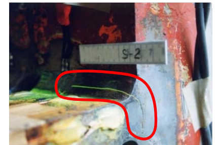
鋼製橋脚隅角部のクラック
