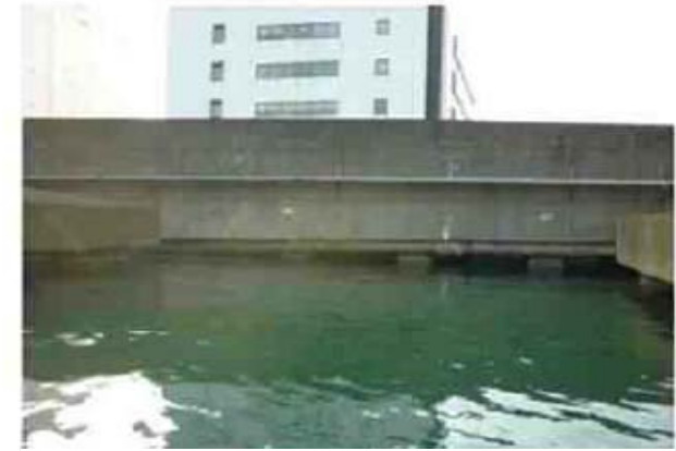
満潮時の栈橋構造 (海面近接部)
