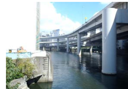
基部が水中にある鋼製橋脚(江戸橋JCT)
