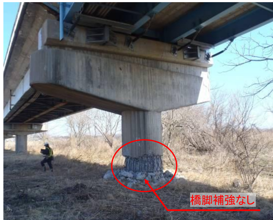
県道（観測震度：震度5弱）
