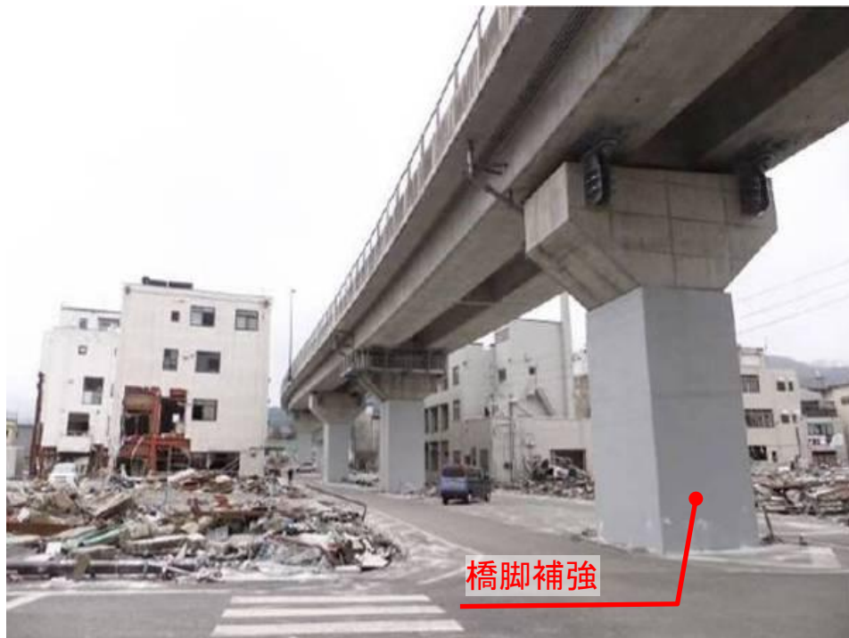
国道45号（観測震度：震度6弱）
