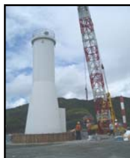
▲航路標識の基礎を補強▲
