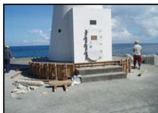
▲航路標識の基礎を補強▲
