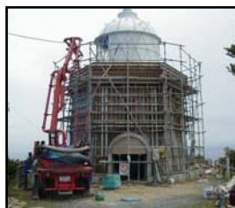
▲鉄筋コンクリートを用い建物及び基礎の補強を実施
