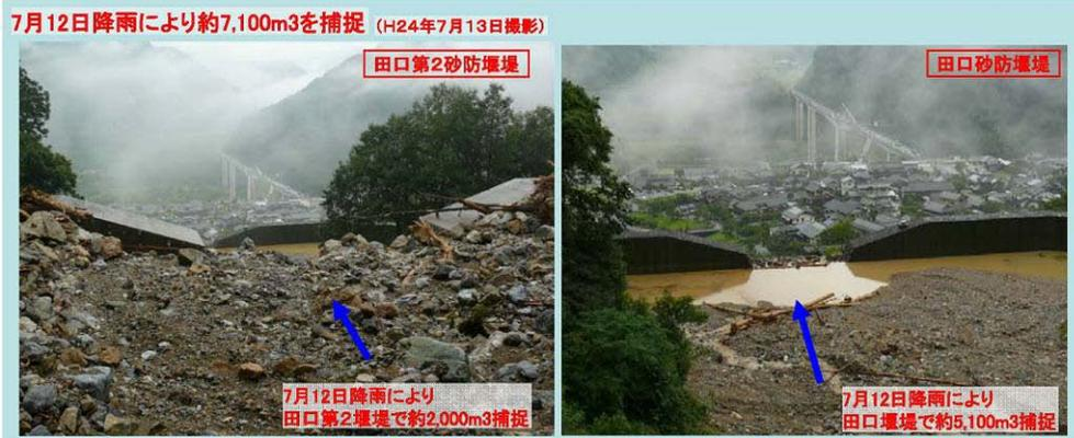
2基の堰堤が土砂を捕捉し、土石流被害を未然に防止
