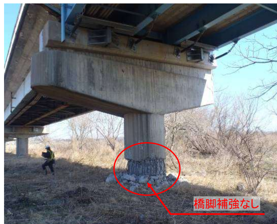
県道（観測震度：震度5弱）
