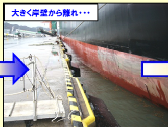
大きく岸壁から離れ...
