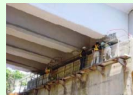
目視、打音検査
