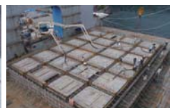
防波堤本体製作現場 (H24.8)
