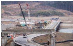
旧橋下部撤去中 (H25.2)
