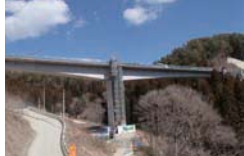
(仮)物倉橋施工現場
