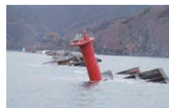
湾口防波堤の被災状況 (H23.3)
