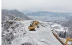
宮古市千徳地区の道路現場
