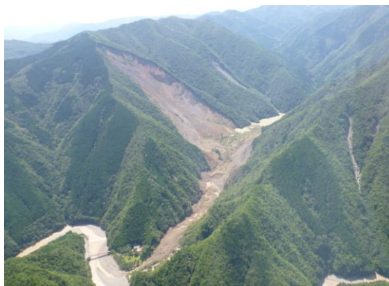
▲奈良県五條市大塔町赤谷 河道閉塞 【写真提供／近畿地方整備局】
