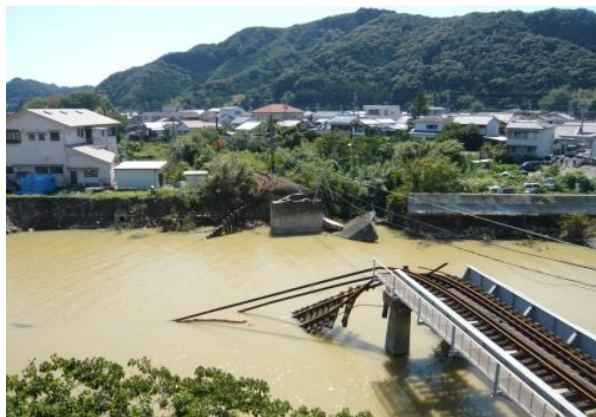
▲JR紀勢線那智川の鉄橋流出【写真提供／近畿地方整備局】
