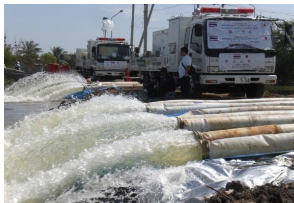
▲ポンプ排水活動状況
