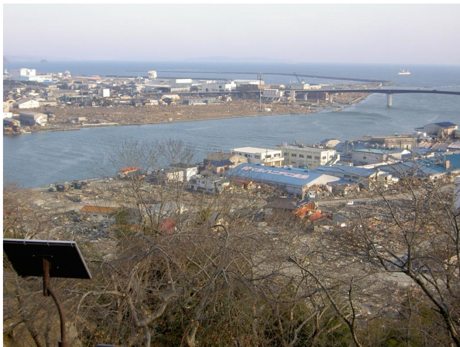
旧北上川河口部の被災状況（宮城県石巻市）
