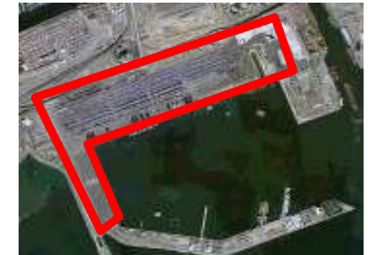
ロングビーチ港 Pier T
