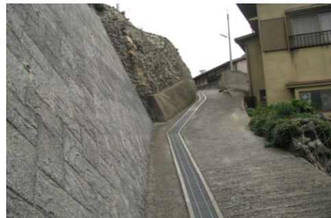
道路法面の状況（整備後）
