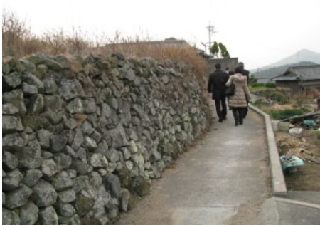
道路法面の状況（石垣積み）
