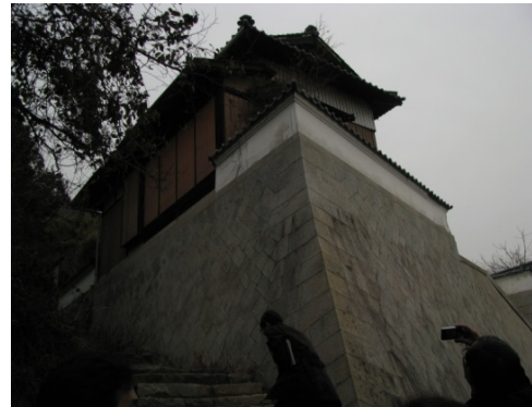
島内家屋の状況（石積み）
