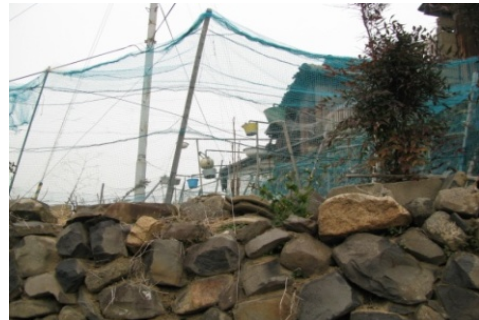
道路法面の近景（石垣積み）
