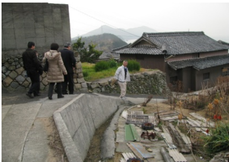
道路法面の状況（整備後）
