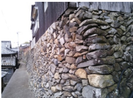
島内家屋の状況（石積み）
