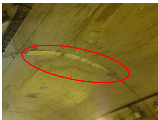
はく落対策工（鋼板）設置状況 （覆工目地沿いに設置）
