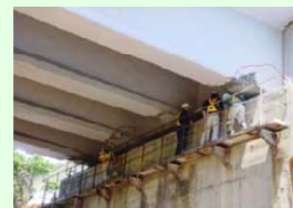
目視、打音検査
