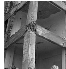
最近の接合部の地震被害
