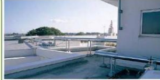
5 本校運動場の奥段を壁からプールへ転送するための橋上配管。
