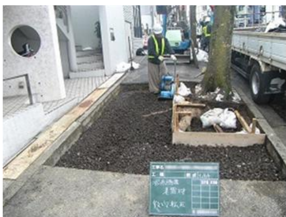
③施工中（路床部に特殊な土壌を設置）
