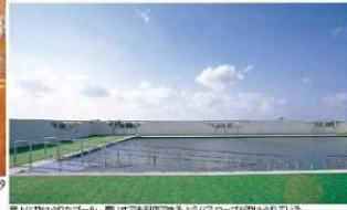
4 屋上に増設されたプール。車いすでも利用できるようにスロープが設けられている。
