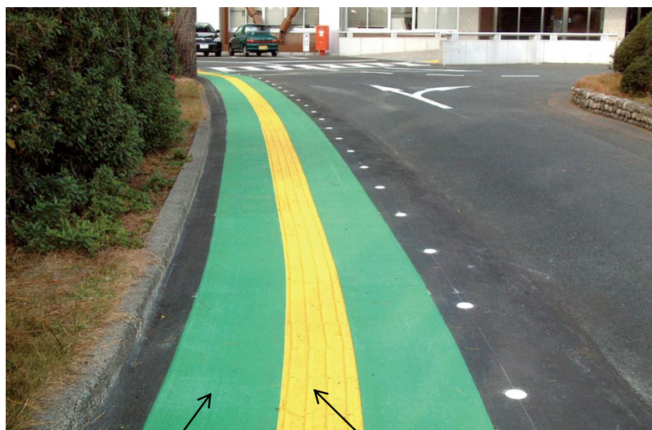
溶融噴射式路面カラー塗装
