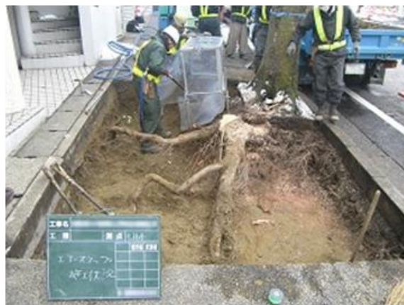
②施工中（既存の根系を傷めないよう掘削）
