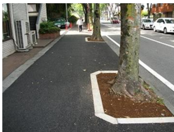
④完成（舗装完了、植樹ますは大きめに）
