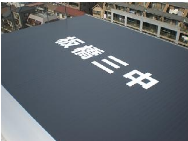
屋内運動場の屋根に書かれたヘリサイン
