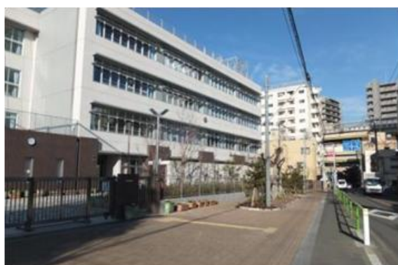
区道と一体化した自主管理歩道 (既存樹木を残す)
