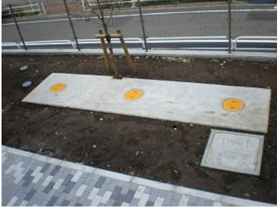
体育館の裏にマンホールトイレを3基設置
