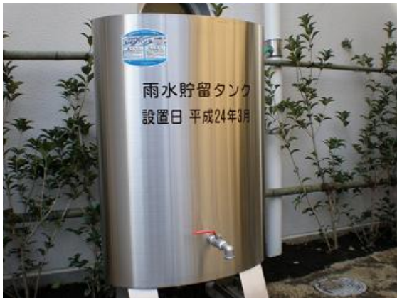
雨水も有効活用 雨水貯留タンク
