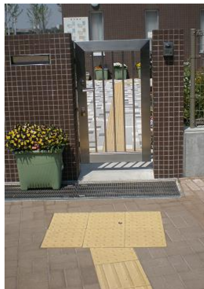
歩道から正門入口まで敷設された 視覚障害者誘導用ブロック
