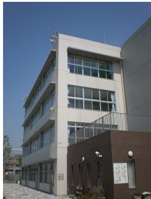
屋上に校庭用照明を設置
