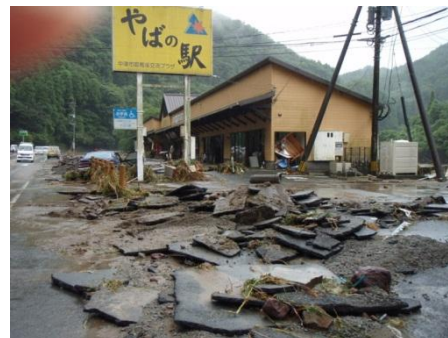
商業施設の浸水被害状況(耶馬溪町柿坂) (平成24年7月3日洪水)
