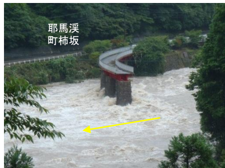
耶馬溪町柿坂 左岸側より第2山国川橋を望む (平成24年7月3日洪水)
