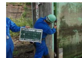
ゲート設備の点検・整備
