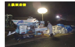
土のう製造機の貸与 H24年九州・北部豪雨
