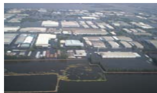
ロジャナ工業団地(タイ)の 工場建屋の水没の様子
