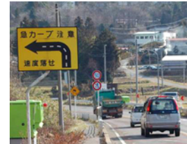
写真3 現道の線形不良箇所（R=75m）
