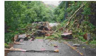
写真1 H18.6土砂災害時の状況
