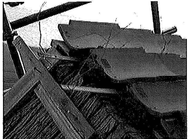
写真-57 土葺き棟部分
