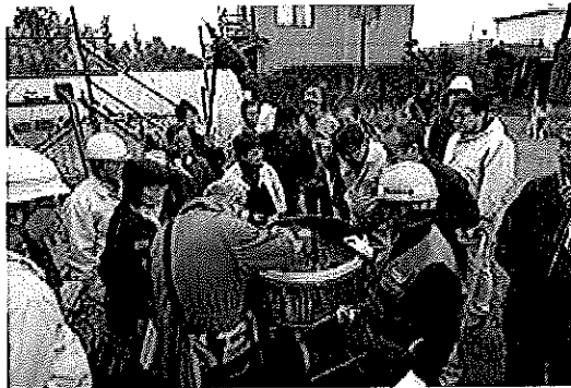
写真-28 荒壁土攪拌
