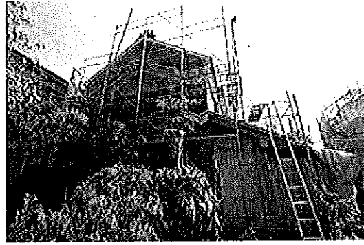
写真-20 真壁地区内修復現場
