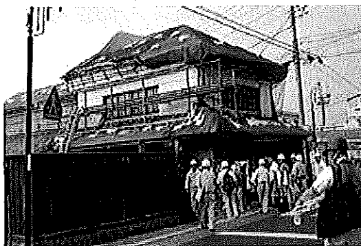
写真-2 調査物件外部被害状況
