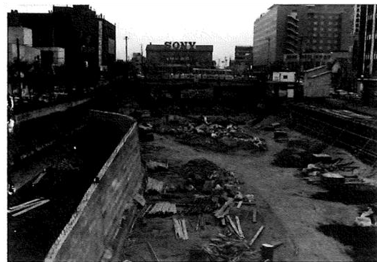
(工事時の状況)
