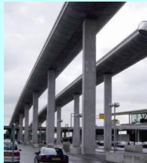
シャルル・ド・ゴール空港の アクセス道路の橋脚
