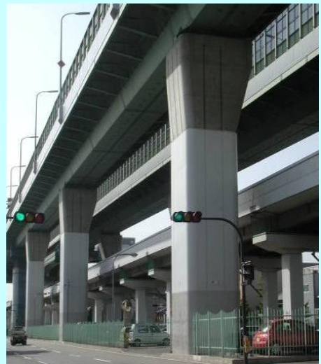
阪神高速道路の橋脚
