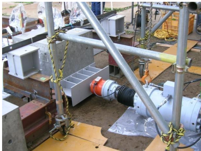
水平載荷試験実施状況
