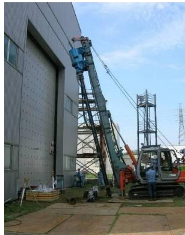
回転貫入鋼管杭斜杭の 施工状況
