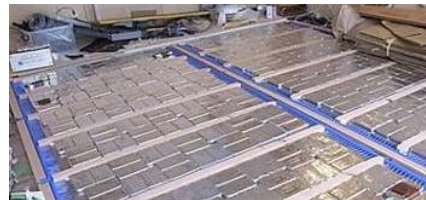
潜熱蓄熱材利用の 床暖房パネル
