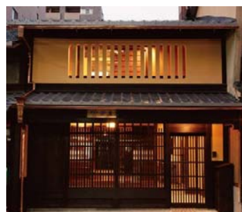
▲京町家再生プロジェクト（改修後）
