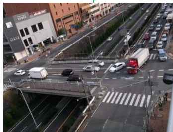
新船場南橋交差点の状況
