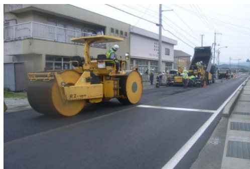
切削オーバーレイによる補修
