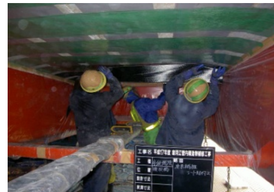
炭素繊維シートによる補修
