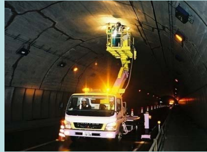
【近接目視によるひび割れ探査】
