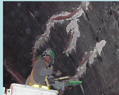
【クラック注入による ひび割れ補修】
