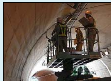
(道路構造物の点検)
