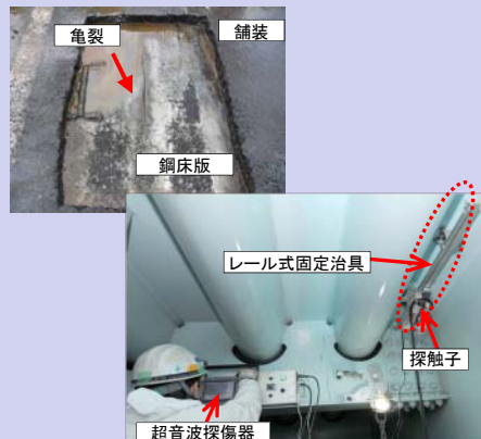
開発した探傷法の適用事例 ※現地での性能検証試験の状況
