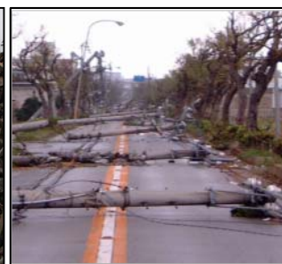
(台風による道路の被災状況)
