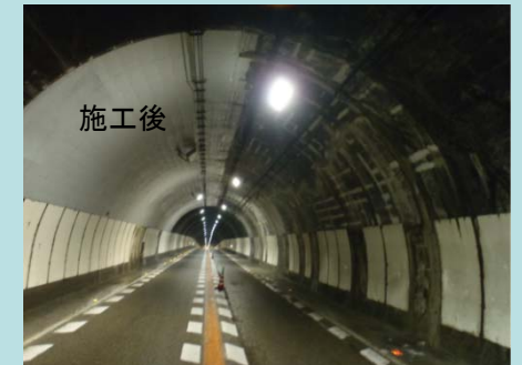
【吹き付けコンクリート(繊維補強)によるはく落防止工】
