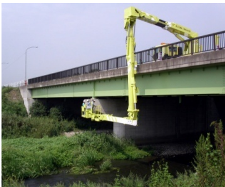
橋梁点検車を使った 橋梁点検
