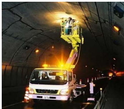
近接目視による ひび割れ探査
