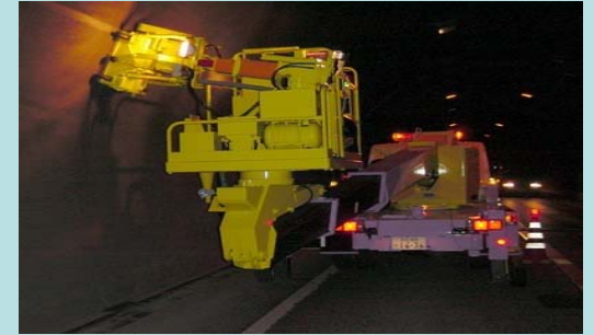
【検査車による非破壊検査】
