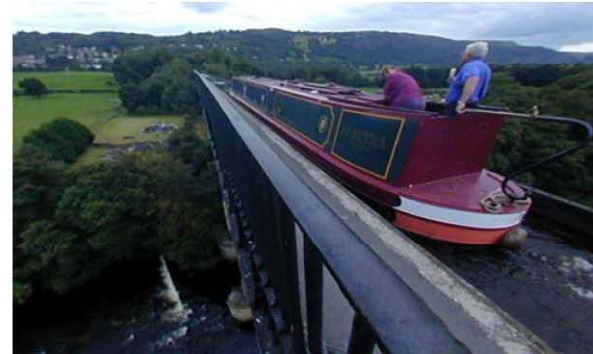
遺産名：ポンテカサルテ水路橋と運河 国：イギリス 所有者：英国水路公社等 保護立法：運河法、史跡地区法、計画（指定建造物及び保護地域）法等
