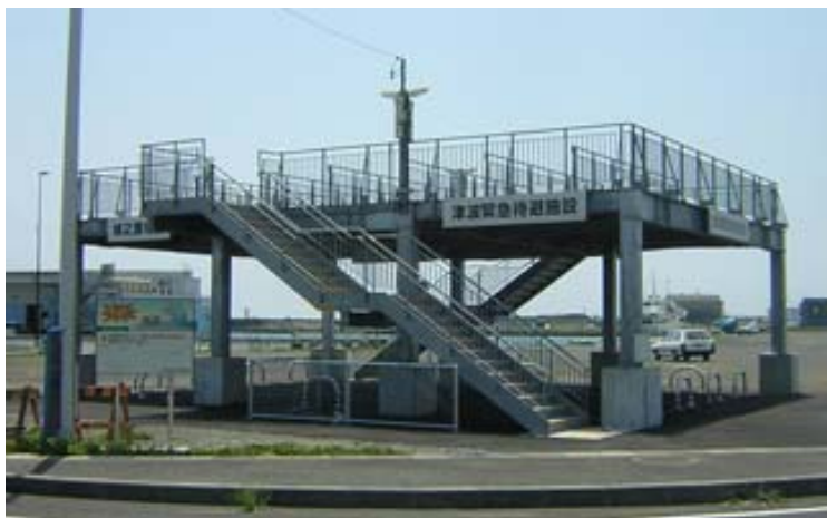
津波緊急待避施設 (焼津漁港 出典:静岡県HP)
