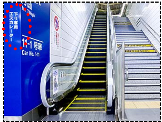
側面壁に「下り専用」の表示がある事例
