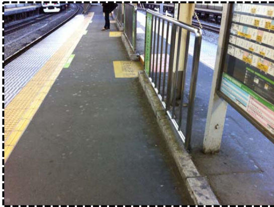
ホーム上に段差がある事例
