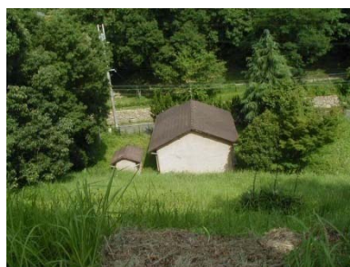
④. 事務庁舎前から庁舎・物置を見る
