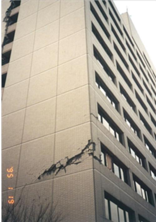
〔柱が破断するなど構造体が損傷し、機能の復旧に時間を要した〕
