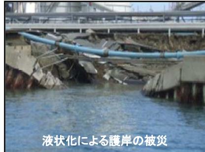
液状化による護岸の被災
