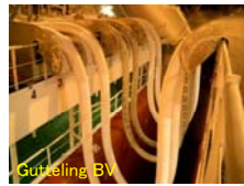
LNG移送ホース
