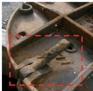
② 腐食に伴う蝶番の破損(Aランク)
