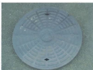
② 残存模様高さ (Aランク)
