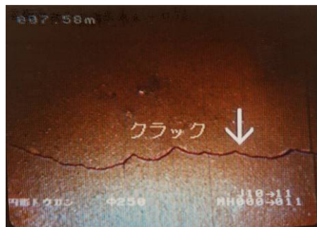
【ランクb】 円周方向のクラックで幅 2mm 以上(HP)
