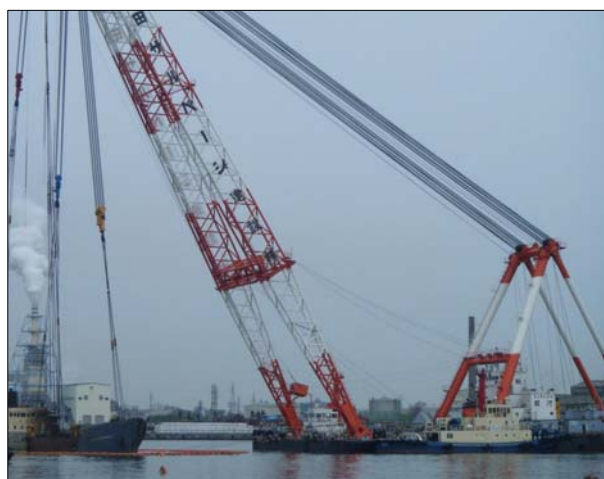
新潟港の沈没船撤去作業 (船舶航行禁止期間：約3ヶ月間)
