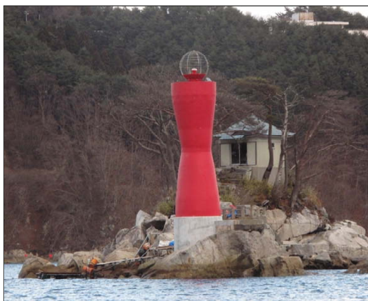
復興のシンボルとして、一般公募によるデザインを採用し復旧
