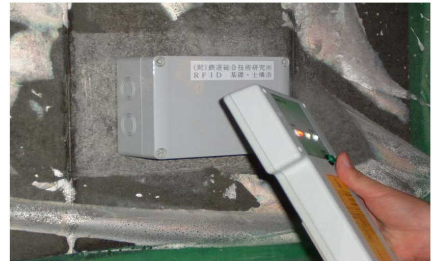
損傷検知センサー/測定状況
