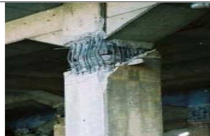
損傷したRC柱
