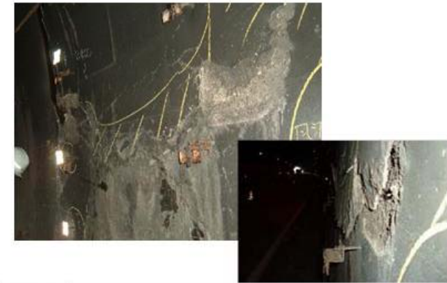
(トンネル覆工の変状状況)
