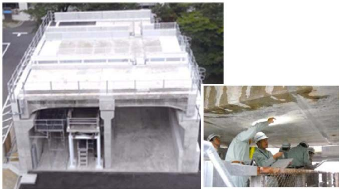
橋梁点検技術の研さん・研究用施設 * 更新のため撤去橋梁を保存: RC、PC、Me、歩道橋 「N2U-BRIDGE」(ニュー・ブリッジ) : 名古屋大学・NEXCO中日本
