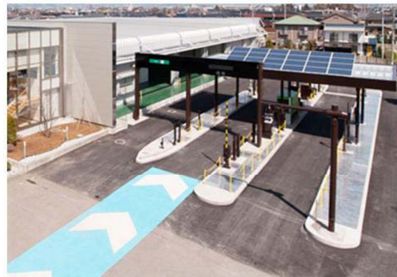
研修施設 テクニカル・トレーニングセンター * ETC実験、保守・点検研修などの施設: ネクスコ東日本エンジニアリング
