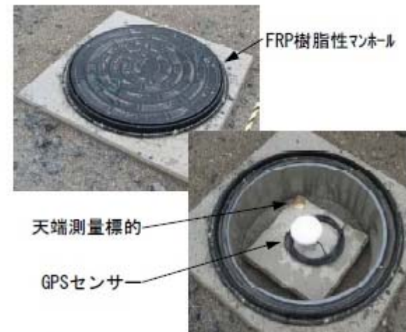
写真-3 マンホール内に設置したGPSセンサー
