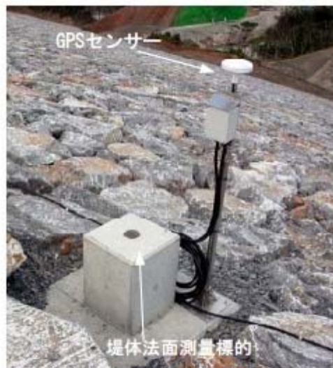
写真-2 外部可動標的基礎に設置したGPSセンサー
