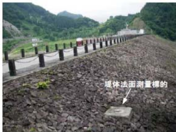
写真-1 フィルダム堤体下流側の可動標的
