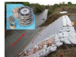
写真-5.1.5 センサー設置状況
