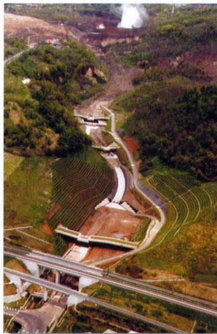
板谷川流域の恒久的な泥流対策として設置された、板谷川1,2,3号砂防堰堤(H14.5.13)撮影
