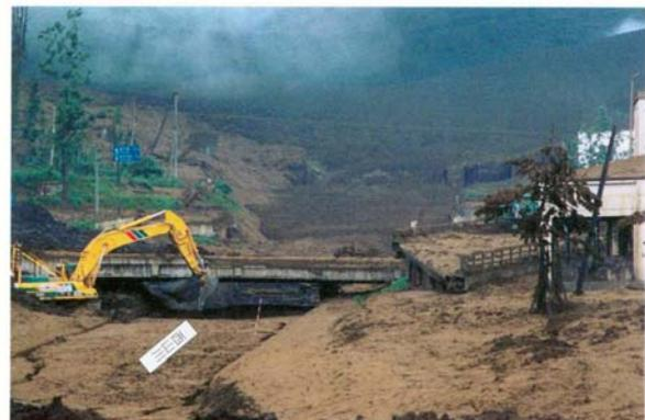
無人化施工による埋塞土掘削の状況（H12.7.14 撮影）
