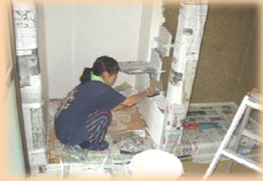
Iターン者自らが 空き家を修繕
