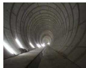
地下トンネル全景
