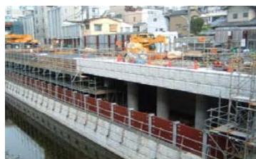
取水施設工事状況
